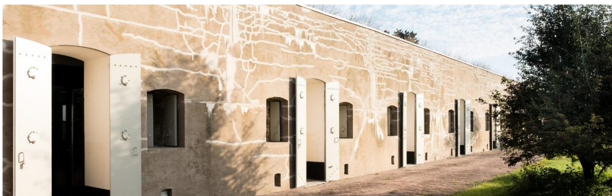
Fort Kijk. Beeld: Hoyschuur architecten en adviseurs.
